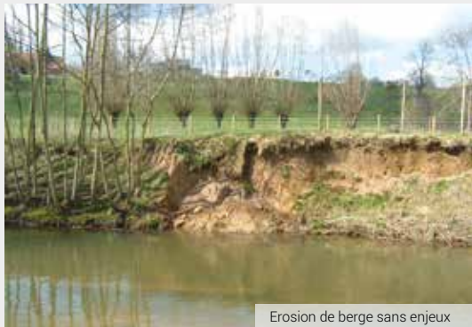
Erosion de berge sans enjeux
