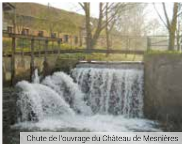
Chute de l'ouvrage du Château de Mesnières
