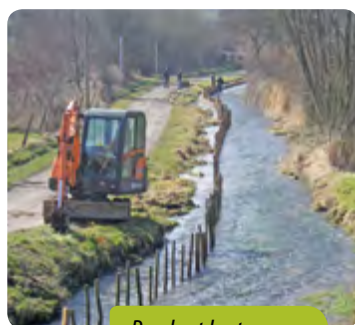
Pendant les travaux
