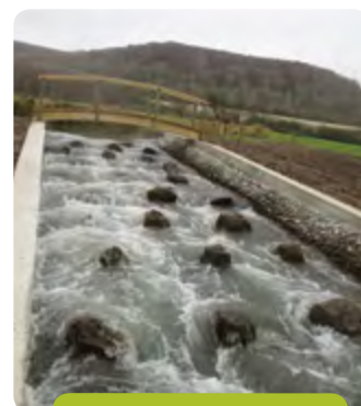
Passe rustique en enrochements sur l'Eaulne à Sauchay.
